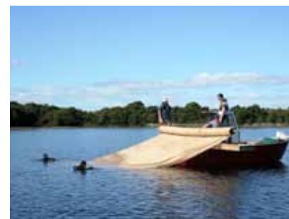
Pose de geotextile dans le lac Corrib.
